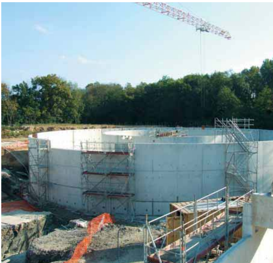
La station d'épuration en cours de construction
